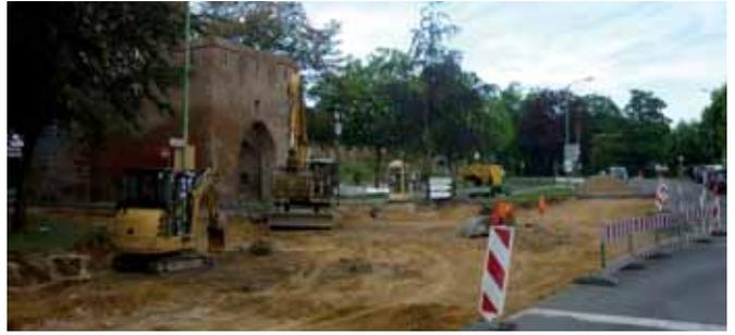
Die Umbauarbeiten im Kreuzungsbereich Kölntor haben inzwischen begonnen. Hier entsteht ein neuer Kreisverkehr. Die Martinsstraße wird in dem Abschnitt bis zur Stadtmauer saniert. Die Straße ist in diesem Bereich derzeit nur einspurig befahrbar, wobei jedoch durch die versetzte Ampelschaltung eine Befahrung in beide Richtungen möglich ist. Das Kölntor ist für den Verkehr komplett gesperrt. Die Bauarbeiten sind voraussichtlich im Oktober 2011 abgeschlossen.
